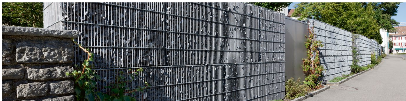
Lärmschutzwand, Füllung Alpenkalk schwarz-weiss
