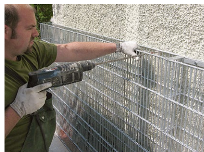
Montage Fassadenkörbe
