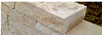
Abdecksteine zu Reb- und Römermauerwerk
